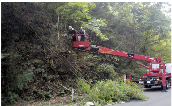
▲高所作業車により法面の樹木を伐採
